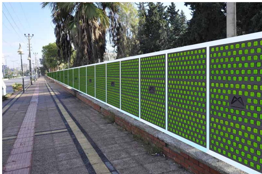
Fig. 3. Barieră de izolare realizată din panouri fonoizolatoare și fonoabsorbante din materiale reciclate
