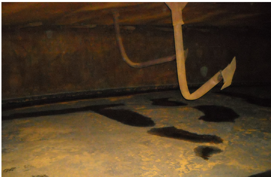
Fig. 4a – Picior deteriorat la interior
