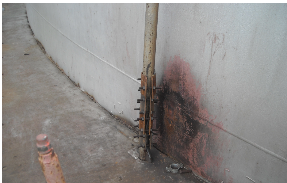
Fig. 6 – Conducta DN50 la serpentină spartă
